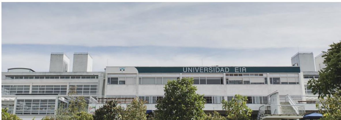
Fachada de la sede principal de la EIA, en la Vía al Aeropuerto José María Córdova, Envigado (Antioquia).
